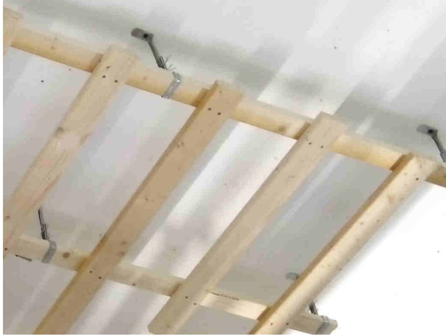
Bild 3: Ansicht der Unterkonstruktion mit Abhängung
